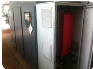
Instalação variador compressor ar comprimido
