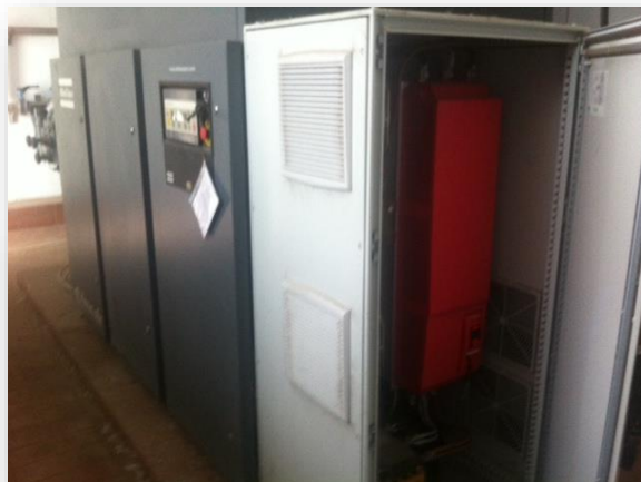
Instalação variador compressor ar comprimido
