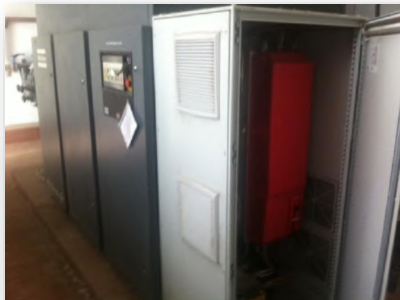
Instalação variador compressor ar comprimido
