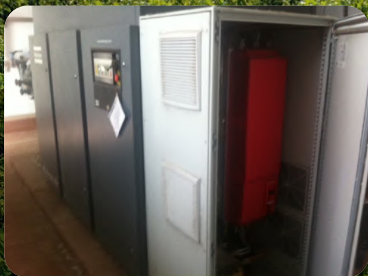
Instalação variador compressor ar comprimido
